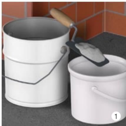
Benötigte Menge Quarzsand (0,1–0,6 mm) in sauberen Mischeimer abfüllen, BIKUCOAT-SMP ECO dazugeben (Mischverh. 1:5 Harz : Sand), dann mit Rührwerk anrühren.
